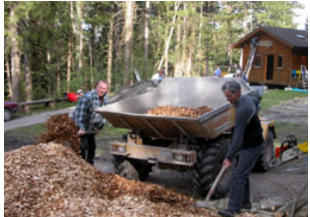
Die Umgebungsarbeiten beim Lehrbienenstand standen im Mittelpunkt.
